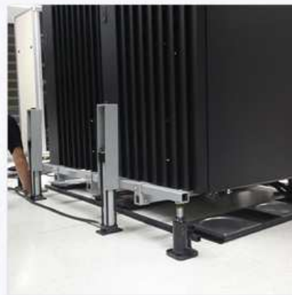
[ラックを持ち上げて設置]
