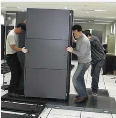
[免震テーブルの設置]
