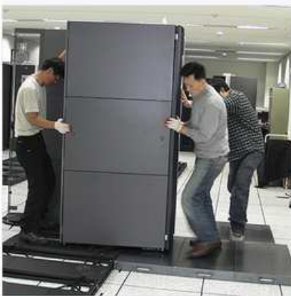
[免震テーブルの設置]
