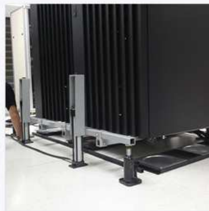
[ラックを持ち上げて設置]
